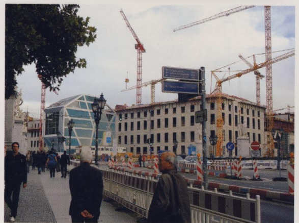
ベルリン ウンター・デン・リンデンの工事風景
